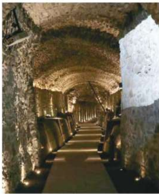
Túneles segunda etapa
