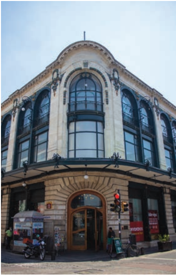
Edificio francés, 2 Norte y 2 Oriente. Ciudad de Puebla.
